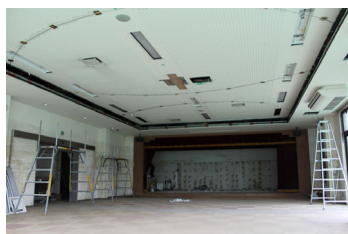
ケーブルによる天井の補強
